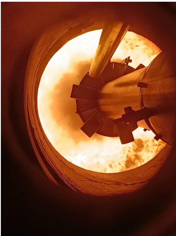
Figure 6. Auxiliary fuel fire (Valtteri Liimatainen).
